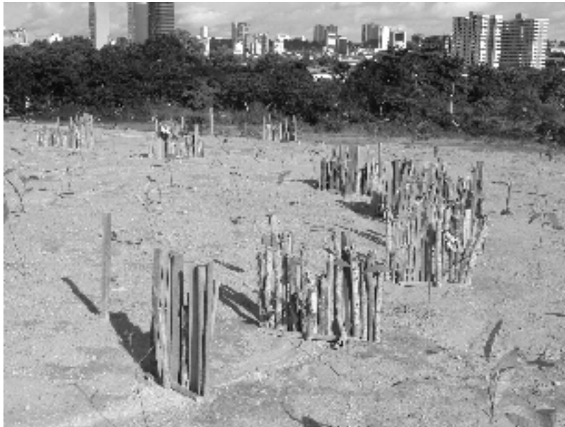
Figura 04 – Pequenas barragens de contenção na área do plantio com objetivo de conter a ação do escoamento superficial concentrado (sulcos). (Vieira, 2004).
